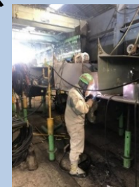
溶接作業の様子
